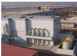
A planta usa uma avançada tecnologia sustentável de baixo custo discreta (LUCAS) que combinava as vantagens da tecnologia convencional e a tecnologia o reactor de batelada sequencial (SBR). Em cada unidade de reactor há uma sucessão de três processos, designadamente: a acumulação, a regeneração e sedimentação. Estes processos são separados ao fechar as válvulas do portão comum. Todo o equipamento segue uma sequência operacional controlado por um PLC.
