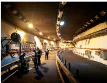
西灣大橋隧道工程
