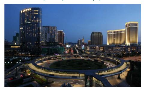
Toda a complexa estrutura assenta em 14 pilares circulares em betão com um diâmetro de 2.5 metros e fundações em mini estacas.
